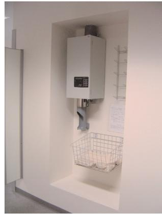
Ilustraciones 6.9. y 6.10. Almacén de material e instalación de tubo neumático.
